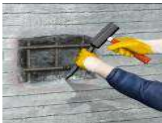
Enlèvement du béton endommagé
