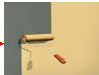
Protection du béton (1ère couche)
