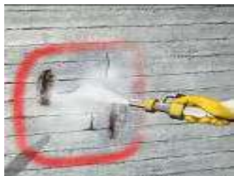
Enlèvement du béton endommagé
