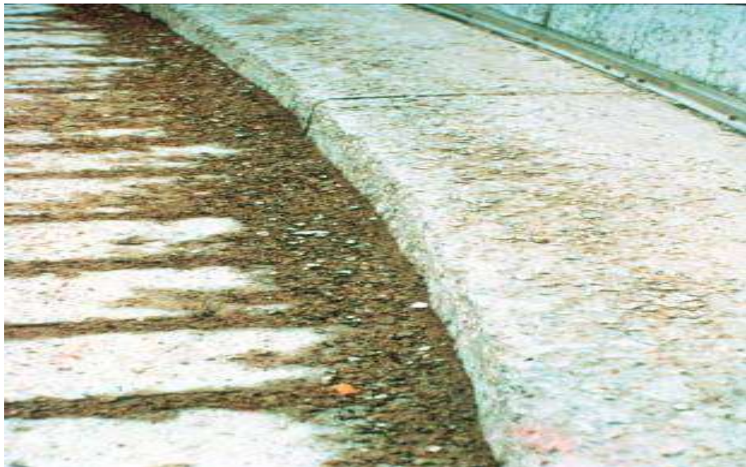
Effets des sels de déverglaçage et du gel
