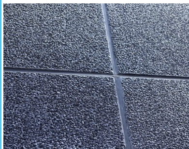
Joint de pierre, briques et béton
