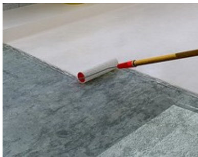
Étanchéité sous carrelage
