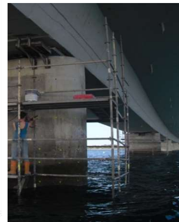
jetée pour l'installation d'anodes discrètes
