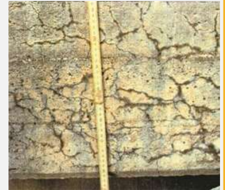
Réaction alcali-silice
