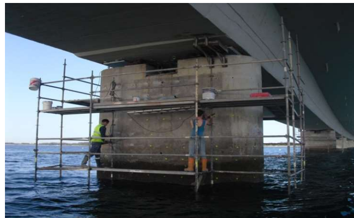
Forage de trous dans une jetée pour l'installation d'anodes discrètes
