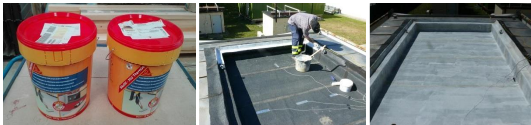
Figura 3. – La aplicación del revestimiento Sikafill 300 Thermic, se ha realizado manualmente, en varias pasadas de aplicación y secado hasta conseguir un espesor medio de 1,5 mm.
