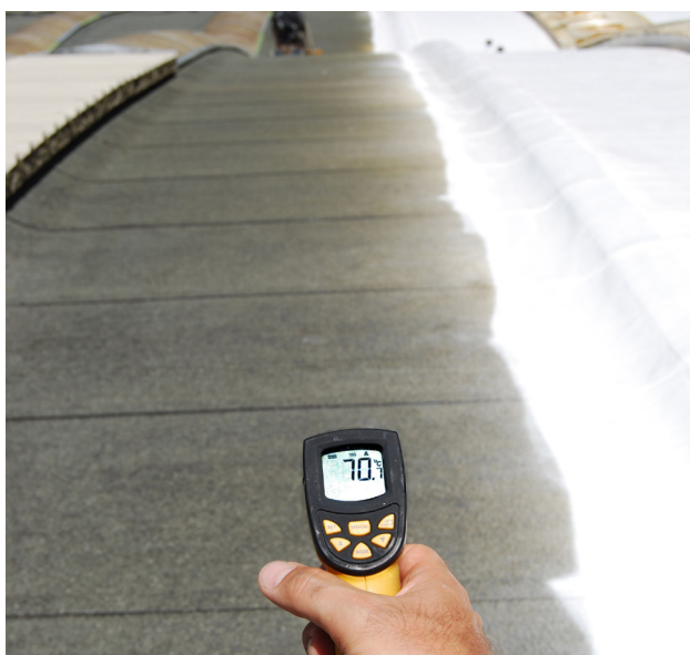
Température du toit avant application de la membrane liquide
