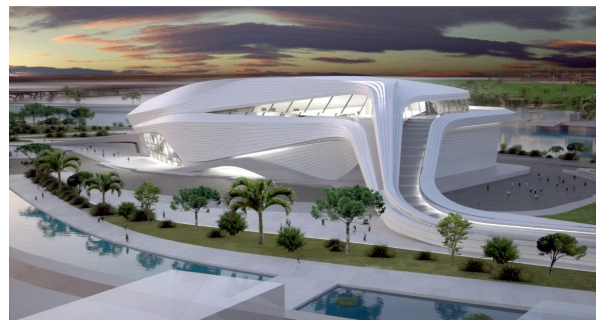
Maitre d'ouvrage : Agence pour l'Aménagement de la Vallée du Bouregreg / Entreprise : SGT Bureau d'étude : Omnium Technologique
