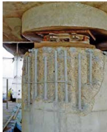
**Méthode 11.2** Application d'un revêtement agissant selon le principe de formation de barrière sur l'armature
